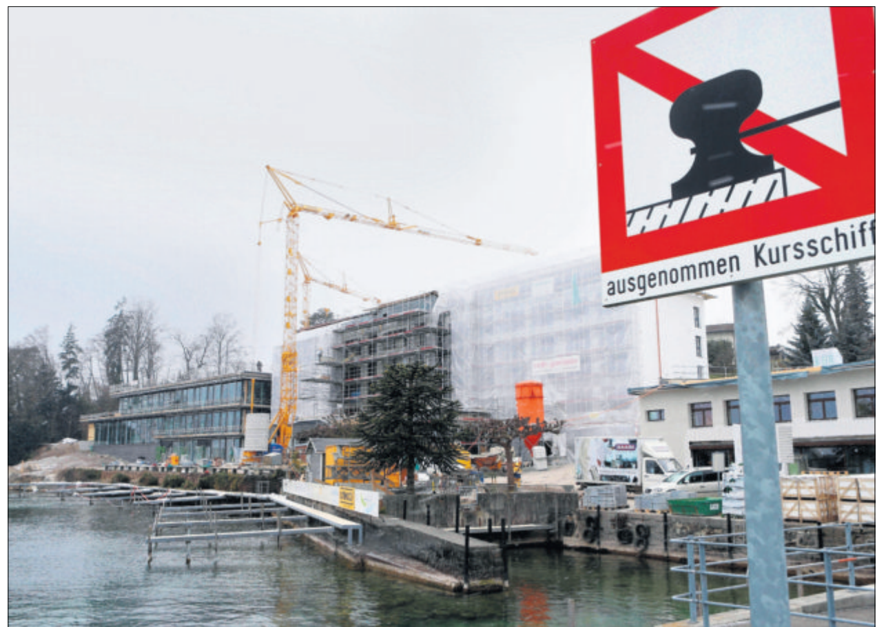
Derzeit im Bau, bald eröffnet: Das Hotel Hertenstein in Weggis soll ab Juni für Gäste offen sein.
